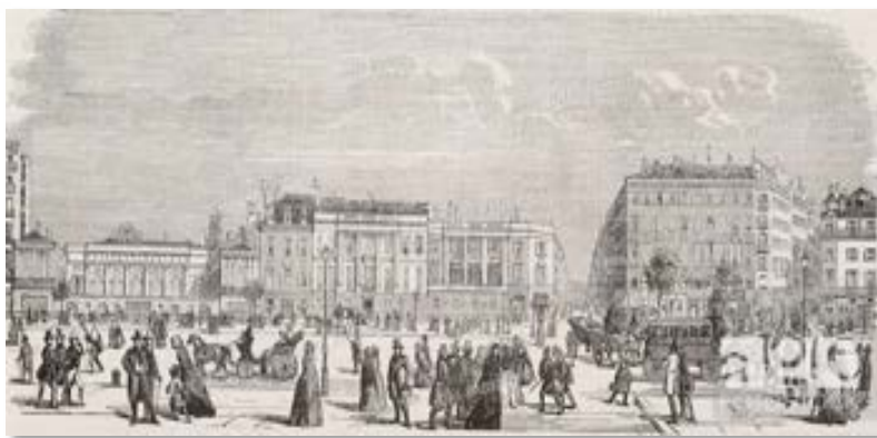
Rue Chaussée d'Antin, 1845. Le case in cui abitarono le famiglie Lefèbvre erano quelle sulla sinistra. Dietro, i grandi giardini che verranno poi eliminati.
