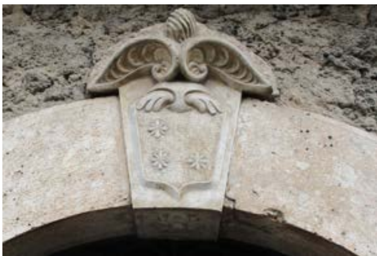
Architrave con le tre stelle di "Casa Lefèbvre", in località Carnello, Isola del Liri.
